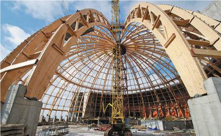
Рис.17. Конструкция купола из клееной древесины.
