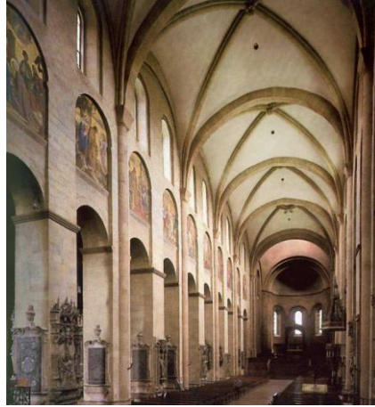
Рис. 115 Собор в Шпейере свод центрального нефа
