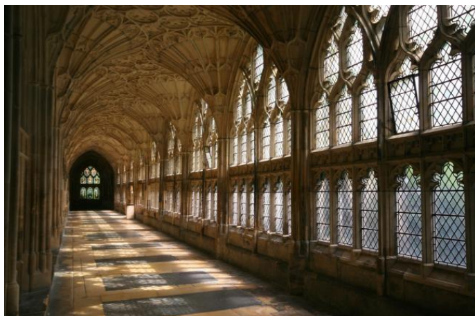
Рис. 204 Веерный свод в соборе Глостера
